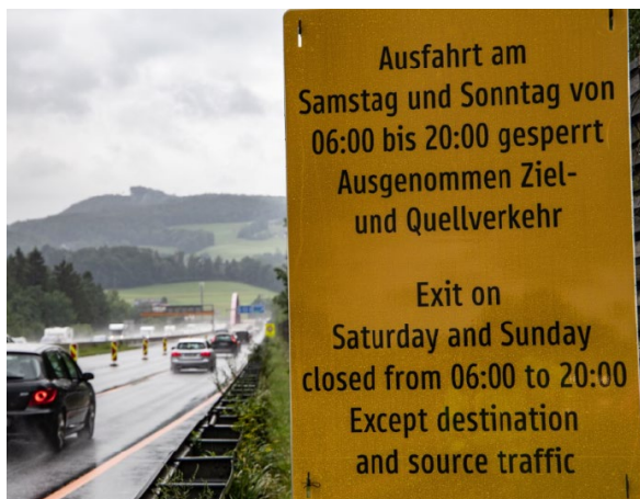
Abbildung 21: Kundmachung der Sperre der Abfahrtsrampe der Anschlussstelle Puch/Urstein Fahrriichtung Villach (Quelle: https://www.fmt-pictures.at/ abgerufen am 24.06.2022)
